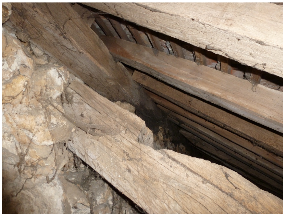
Photo 11 : Embrèvement taillé dans l'arbalétrier d'une demi-ferme de la charpente du bas-côté sud du chœur.
