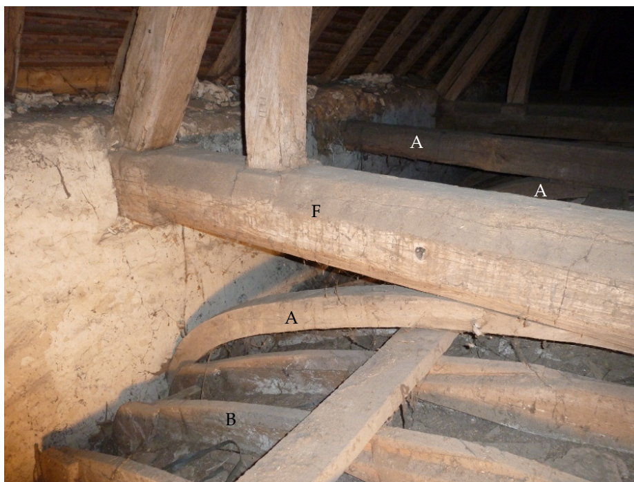
Photo 12 : Différents dispositifs associés aux voûtes en bois de la nef. A : Aisseliers cintrés et poutres intercalées entre les fermes (F). B : Cerces de la voûte supposée du XIX e siècle.
