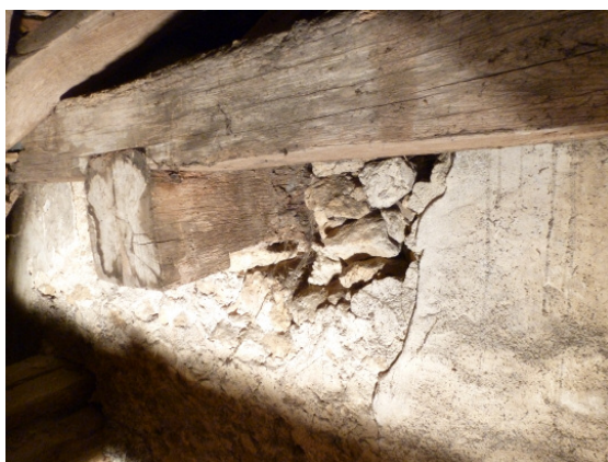
Photo 7 (en haut) : Entrails portant une sablière dans la maçonnerie du mur gouttereau nord de la nef.
