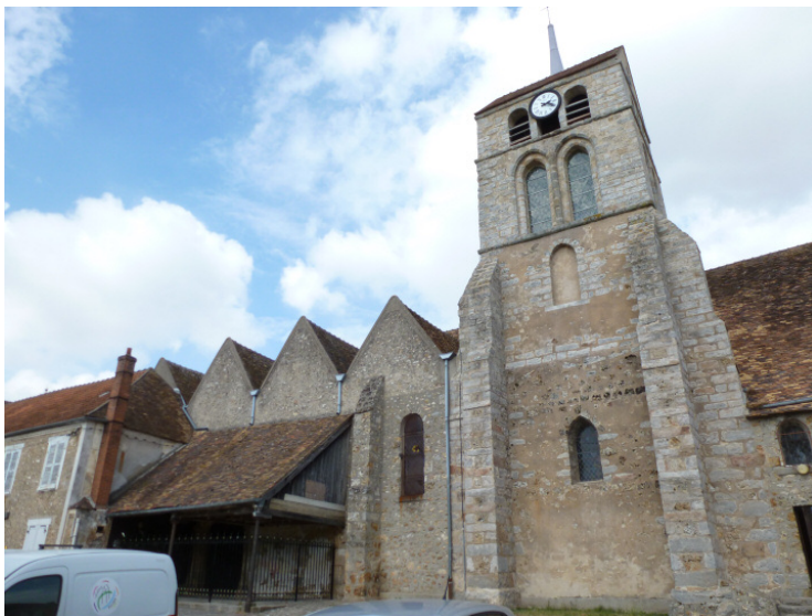
Photo 2 : Toitures du collatéral sud, à l'ouest du clocher.
