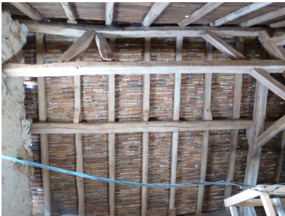
Photo 10 : Charpente du chœur. Chevrans sud suspendus aux pannes par des échantignolles inversées.
