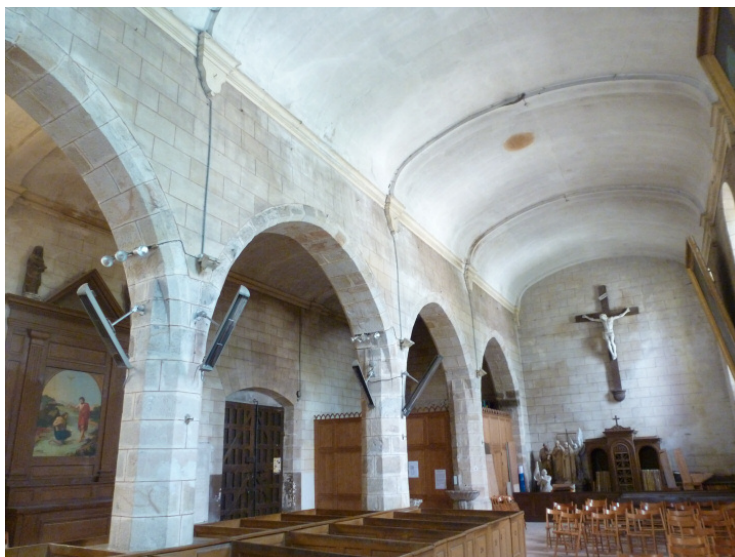
Photo 1 : Vue des deux collatéraux de la nef, depuis le nord et vers l'ouest.
