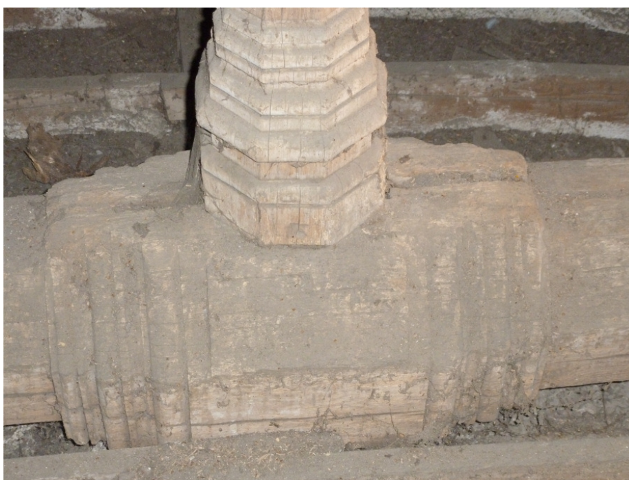
Photo 4 (en haut) : Assemblage poinçon-entrait de la ferme F2 (marque III).
