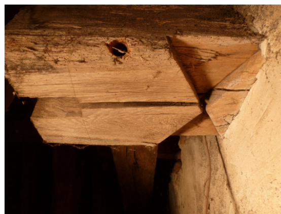
Photo 7 (en haut) : Entrails portant une sablière dans la maçonnerie du mur gouttereau nord de la nef.
