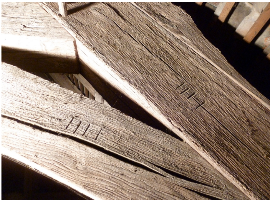
Photo 6 : Marques d'assemblages IIII sur l'aisselier sud et l'arbalétrier sud de la ferme F1.
